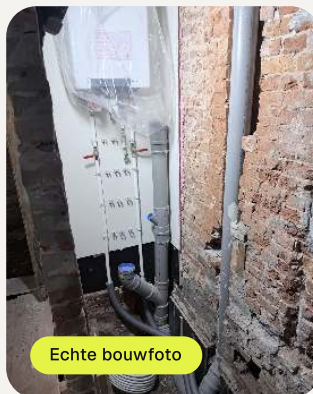
Nieuwe vloerverdeler en riool
